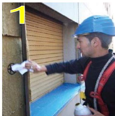
1 Aplicación de promotor sobre perfilería. Dejar secar 10 minutos.
