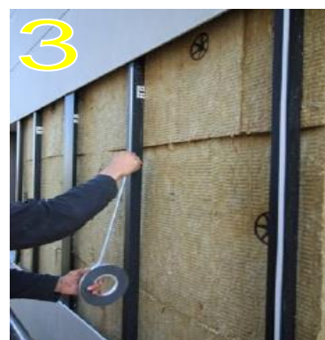
3 Colocación de cinta sobre perfilería. No retirar protector expuesto al aire
