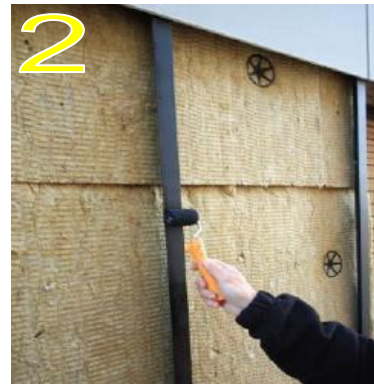
2 Aplicación de imprimación sobre perfilería. Dejar secar 10 minutos.
