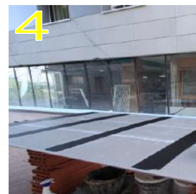
4 Repetir los mismos pasos sobre la placa. Solo en zona de contacto con perfil
